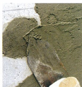
⑤ モルタルの追っかけ塗り
