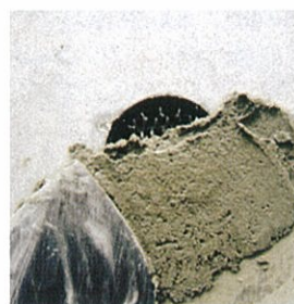
④ スーパーループボンドへの塗込み
