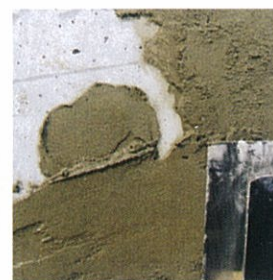
⑤ モルタルの追っかけ塗り
