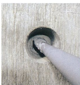
② シーリング材による防水処理
