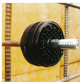
① 取付け・確認
