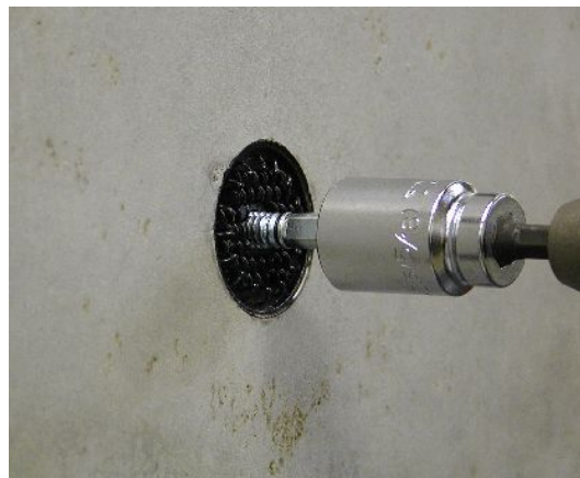
2. 軸セパの取り外し
