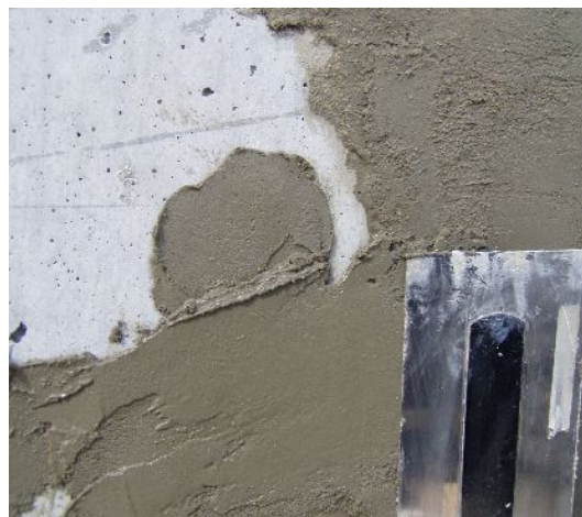
5. ATB入りモルタル の 追っかけ塗り
