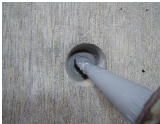
2. シーリング材による 防水処理
