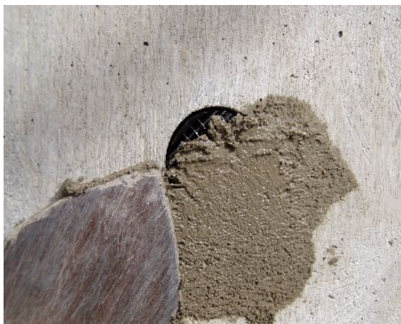
4. ループ部への ATB入りモルタル 塗込め
