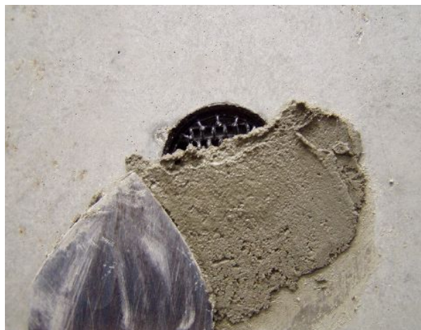
4. ループ部への ATB入りモルタル 塗込め
