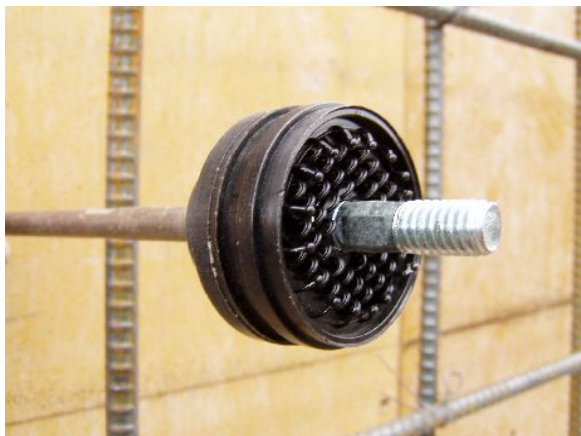
1. スーパーループボンド の取付・確認
